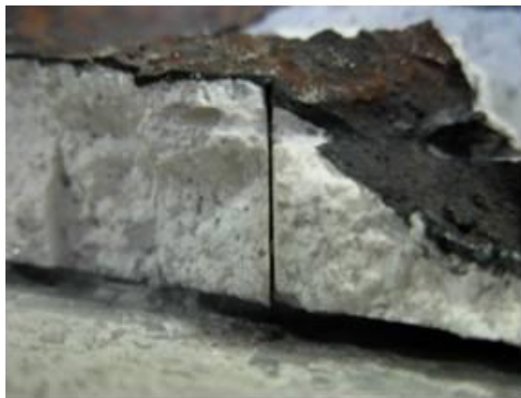
Figura 8: Plugue A post mortem apresentando as situações em que ocorreu a obstrução do slit .
