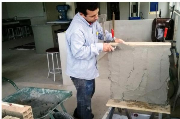
Figura 4 – Revestimento das paredes
