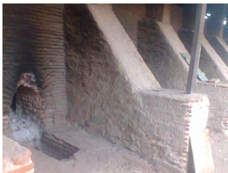
Figura 04. Fornalha de um forno tipo Paulistinha. Fonte: Mesquita, 2012.
