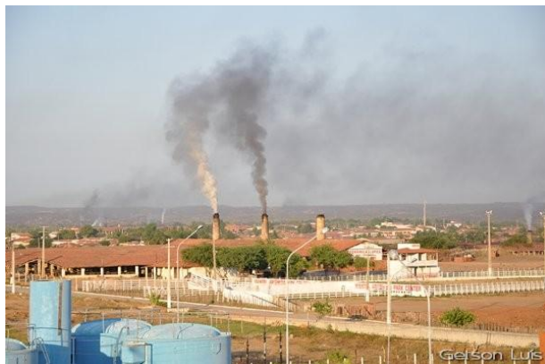
Figura 11. Forno com excesso de lenha e outro com excesso de ar. Fonte: http://www.latinoamerica24.com/foto.php?id=41727102 , 2013.
