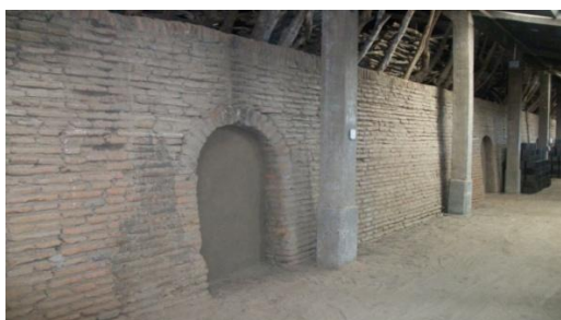
Figura 03. Portas do forno Hoffman fechadas e a lenha em cima do forno. Fonte: Mesquita, 2012.
