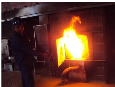
Figura 07. Fornalha aberta de um forno túnel. Fonte: própria, 2013.
