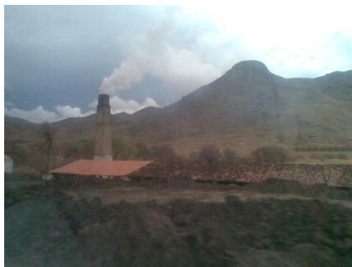
Figura 09. Fumaça branca, quantidade de combustível era menor que a de ar.
