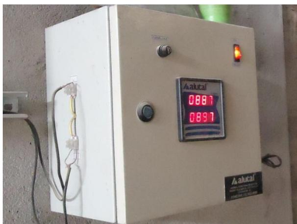
Figura 4: Monitoramento da temperatura de forno com auxílio de termopares.
