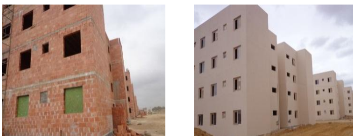
Figura 1 - Edifícios com quatro pavimentos em alvenaria estrutural. À esquerda sem o revestimento, à direita já em fase de acabamento. Fotos: a autora.
