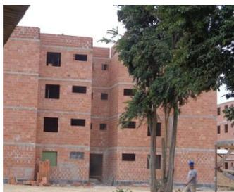
Figura 1 - Edifícios com quatro pavimentos em alvenaria estrutural. Foto: a autora.
