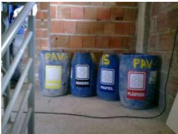
Figura 1 – Bombonas de separação na obra.
