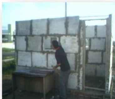
Figura 2 – Aplicação do tijolo com Material compósito
