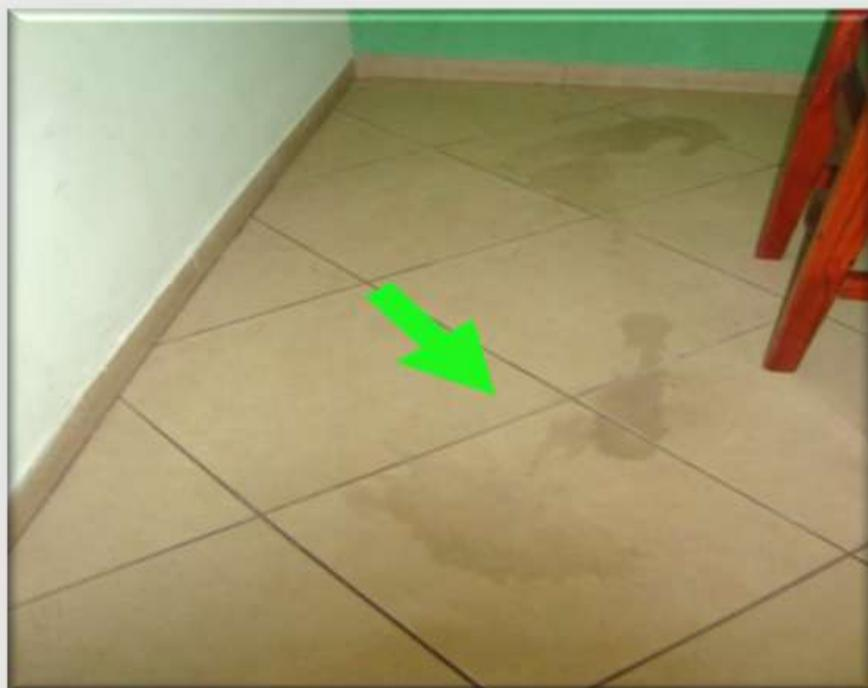
Figura 10 – Defeito provocado por mancha d'água
