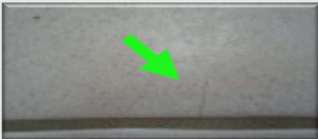
Figura 12 – Defeito trincas em revestimentos cerâmicos
