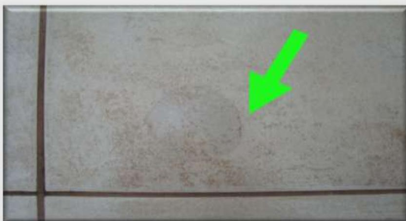
Figura 3 – Defeito bolha em revestimento cerâmico
