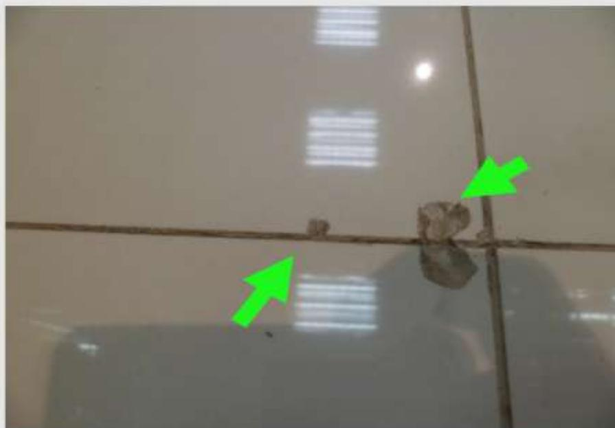
Figura 9 – Placa cerâmica aplicada com o defeito lascamento
