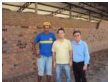
Figura 19. Forno semi-contínuo que está sendo construído. (Fonte: Própria, 2012).
