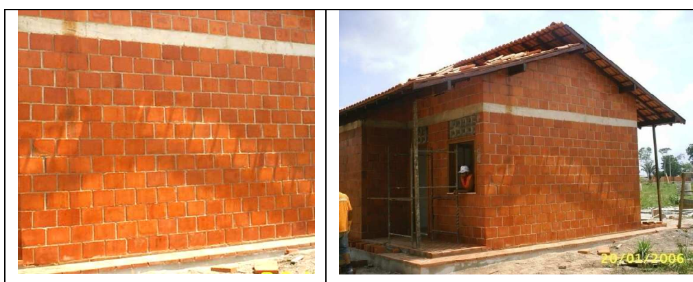
Fig. 06 Aparência da parede e casa construída com blocos estruturais no Município de Barcarena - PA
