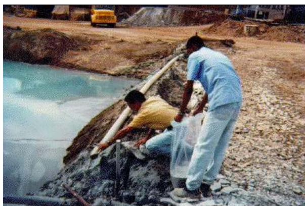
Figura 1 – Descarga da lama na barragem de rejeito de granito
