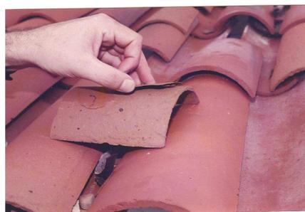
Figura 3 - Telhas com criptorescência
